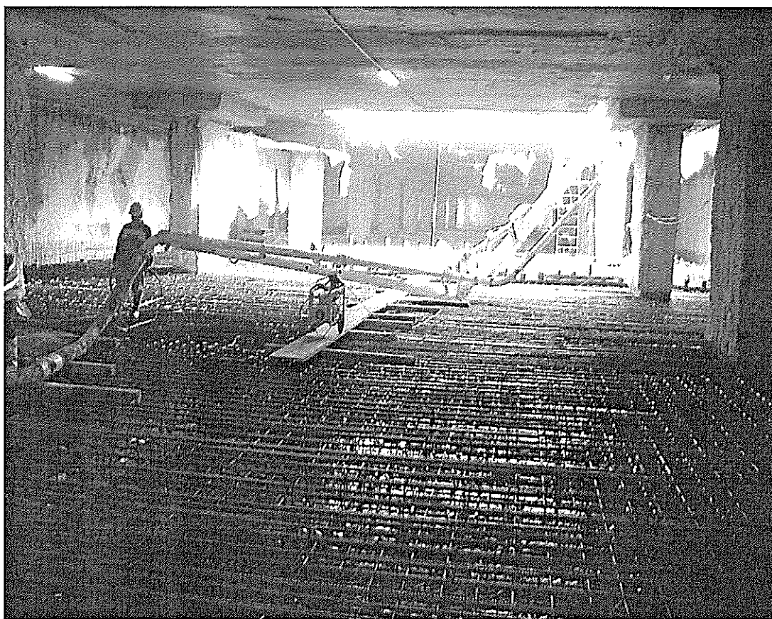
Фиг. 3 Изграждане на метростанция по „Милански метод”
